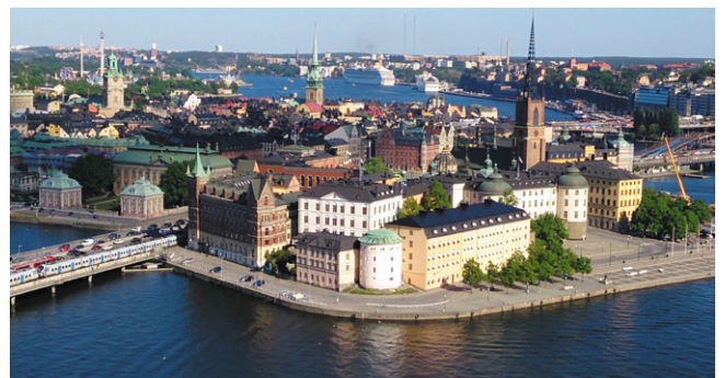
ストックホルム市庁舎から撮影した 旧市街地・ガムラスタン方向
